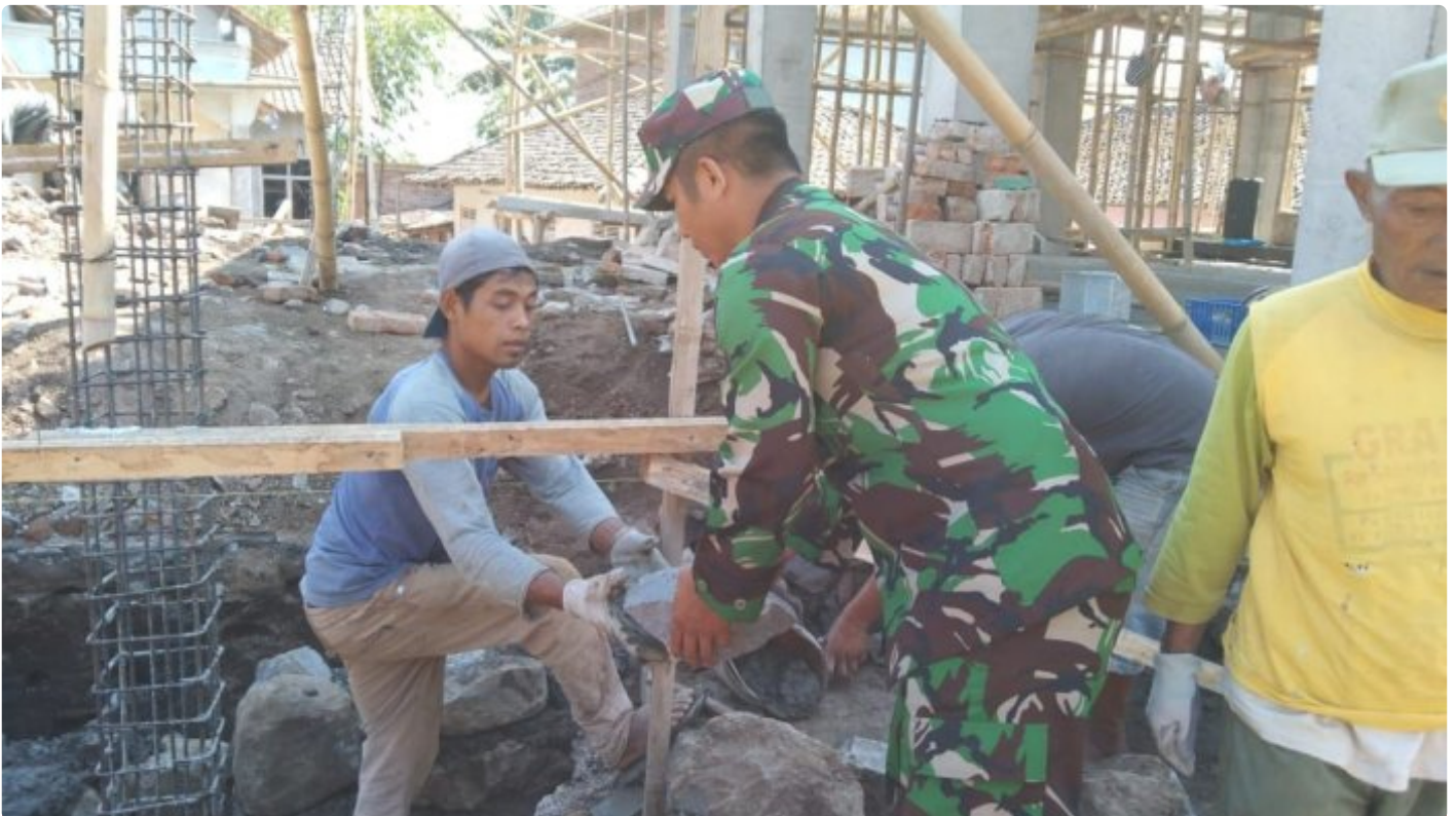
Serda Nasikin bantu pemasangan batu pondasi masjid
